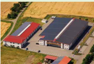
Photovoltaikanlage auf den Firmendächern
